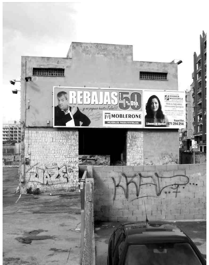
L'edifici va ser esbucat poc temps després que es demanés la seva protecció.
